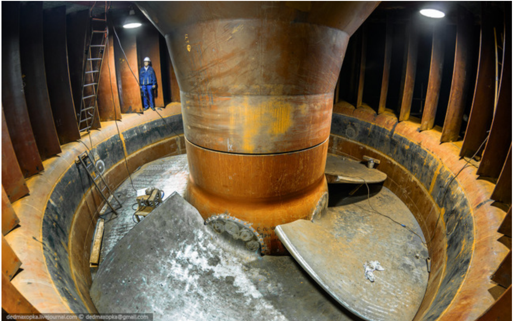
Рис.6 ПЛ турбина Новосибирской ГЭС.
